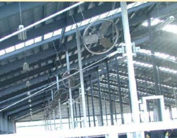
天井からの採光や 換気扇の設置
