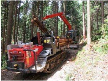
先山での積込作業
